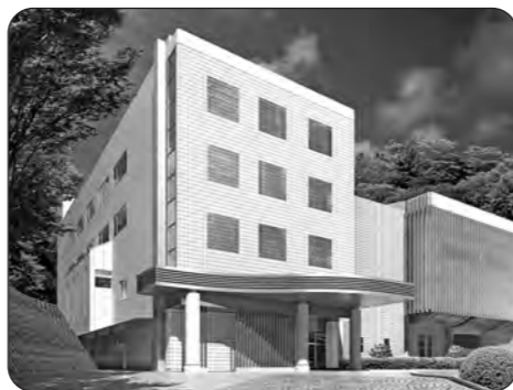
火葬棟わきに新設される式場
